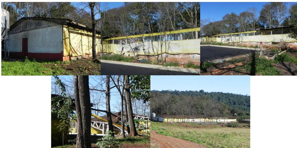
Uma pocilga de alvenaria, coberta com telhas de barro, assoalho piso de cimento, fechada com tela e lona, medindo 892.50 m<sup>2</sup>, a mesma encontra-se com uma parte das tesouras quebradas, inutilizado, devido a um temporal, sendo o restante em regular estado de conservação.
