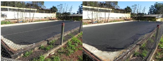
Uma esterqueira, em concreto, revestida em toda sua extensão e profundidade com lona própria, para armazenagem de esterco, medindo 80 m<sup>2</sup>, com profundidade de 04 metros.
