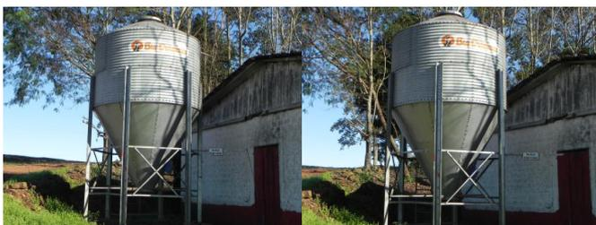
Um silo de chapa galvanizada, marca Biq Dutchann, capacidade para 12 toneladas, com seis pés de apoio, com aproximadamente 10 anos de uso, em bom estado de conservação.
