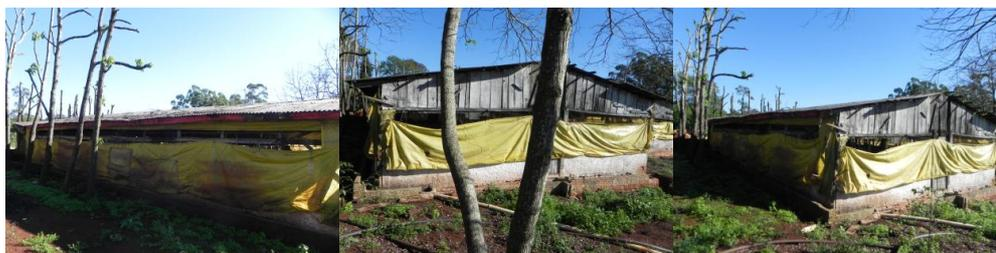
Uma pocilga de alvenaria, coberta com telhas de cimento amianto, piso de concreto, fechado com tela e lona, medindo aproximadamente 160 m<sup>2</sup>, em bom estado de conservação.
