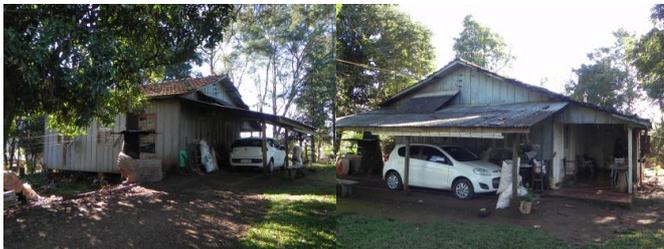
Uma casa mista, metade de madeira e outra metade alvenaria, coberta com telhas de barro, assoalho beneficiado, abertura em madeira, sendo a parte de alvenaria, com tijolos, sem reboco, assoalho revestido com cerâmica, medindo aproximadamente 108 m<sup>2</sup>, em regular estado de conservação
