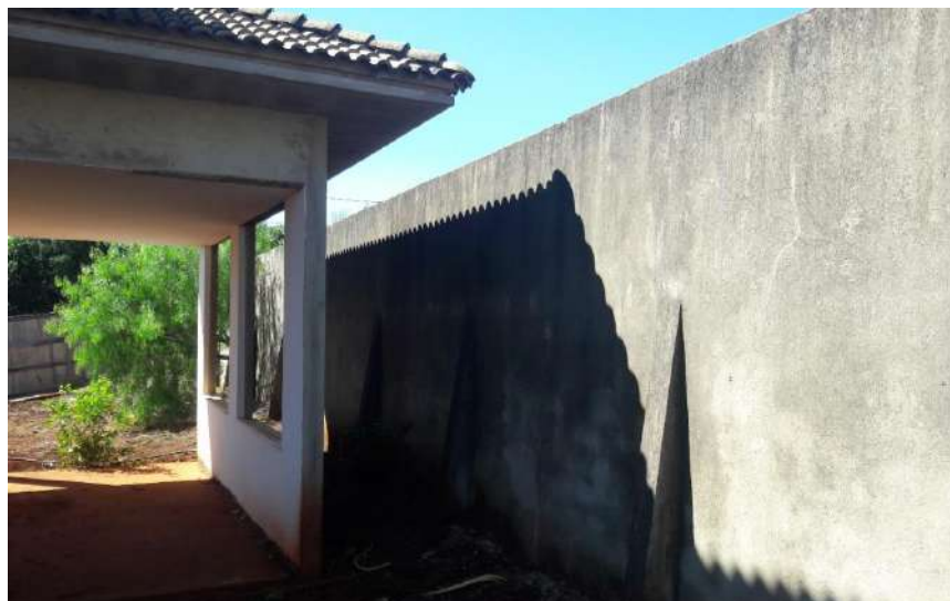
Detalhe da garagem / Muro de arrimo
