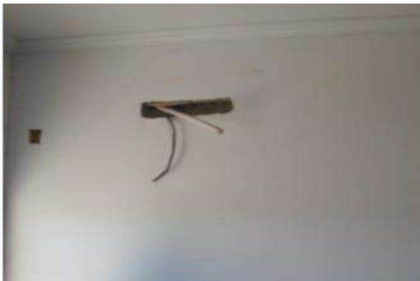
Instalação de ar-condicionado na suíte
