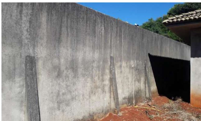
Detalhe do muro de arrimo
